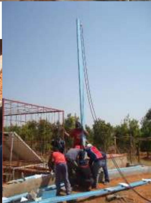
Montage des éléments de charpente du château d'eau de TSARAFARITRA
