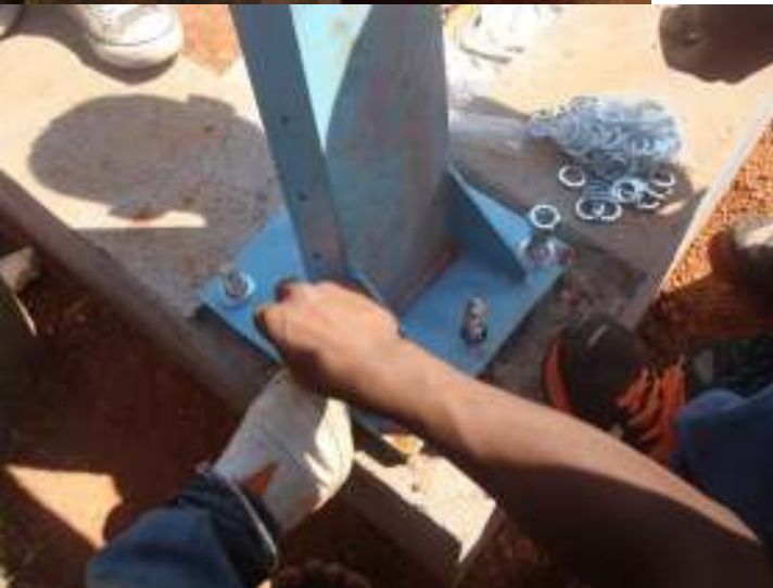
Montage des éléments de charpente du château d'eau de TSARAFARITRA
