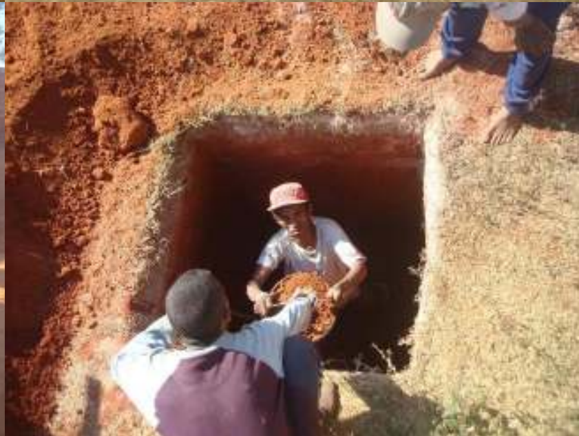
Réalisation des fouilles pour les massifs du château d'eau du site de TSARAFARITRA
