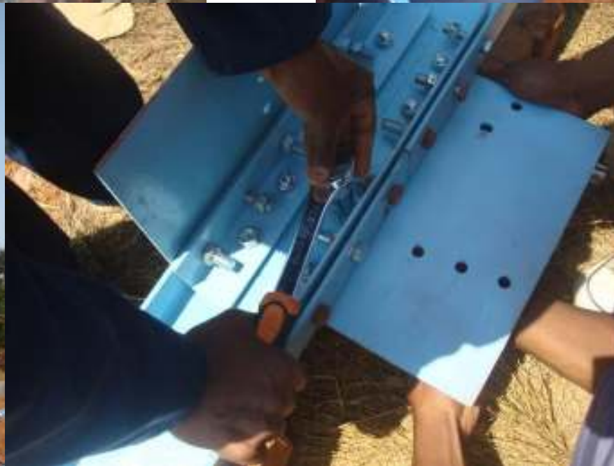
Montage des éléments de charpente du château d'eau de TSARAFARITRA
