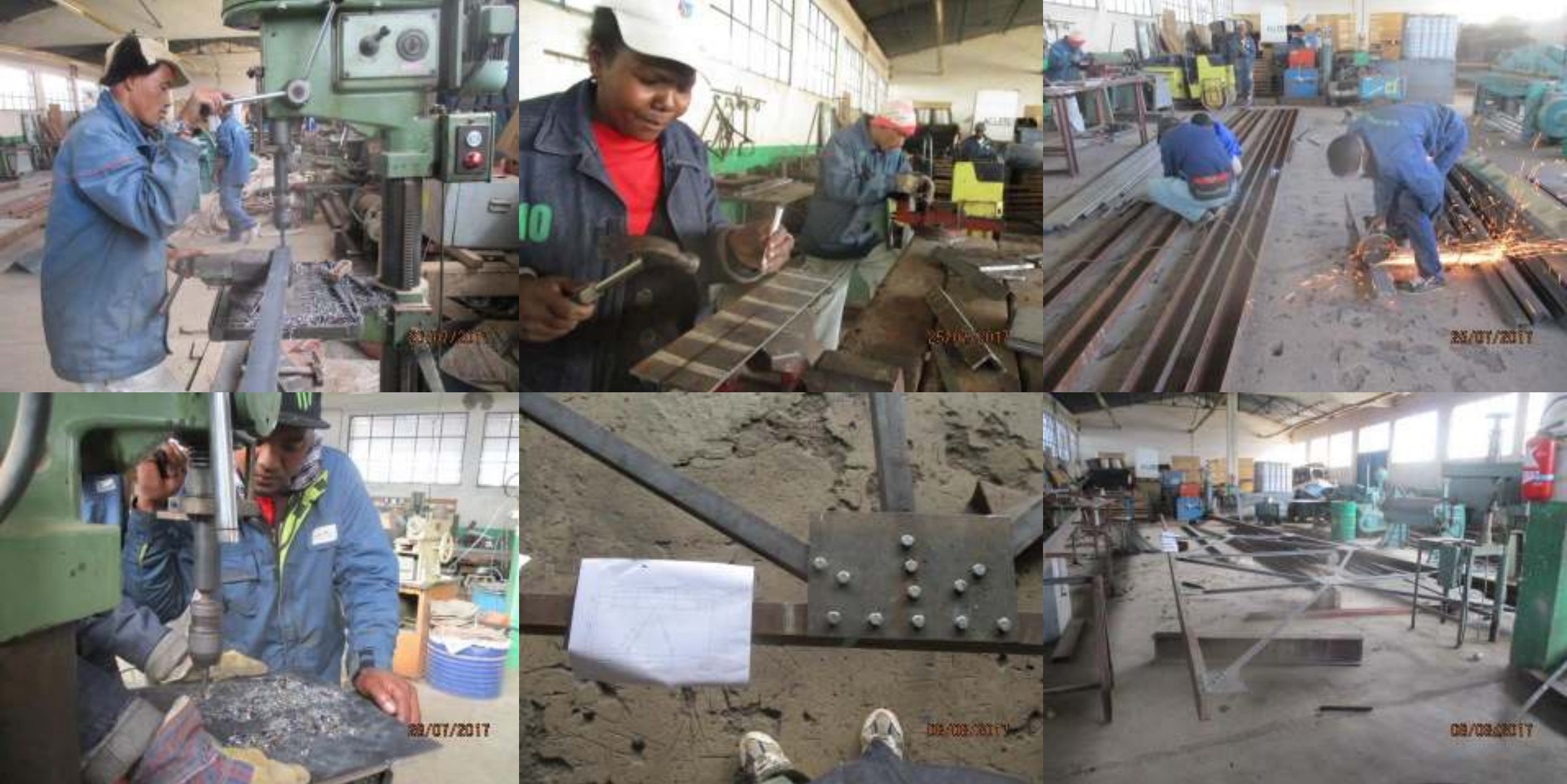
Réalisation des pièces constitutives du château d'eau à l'atelier AKAMASOA
