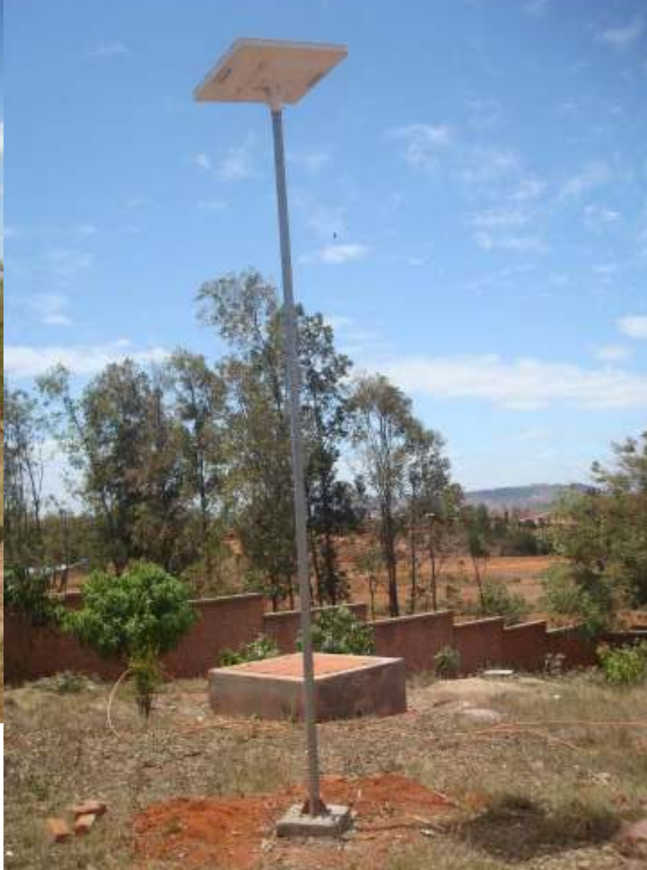
Installation d'un lampadaire solaire pour sécurisation du site de TSARAFARITRA
