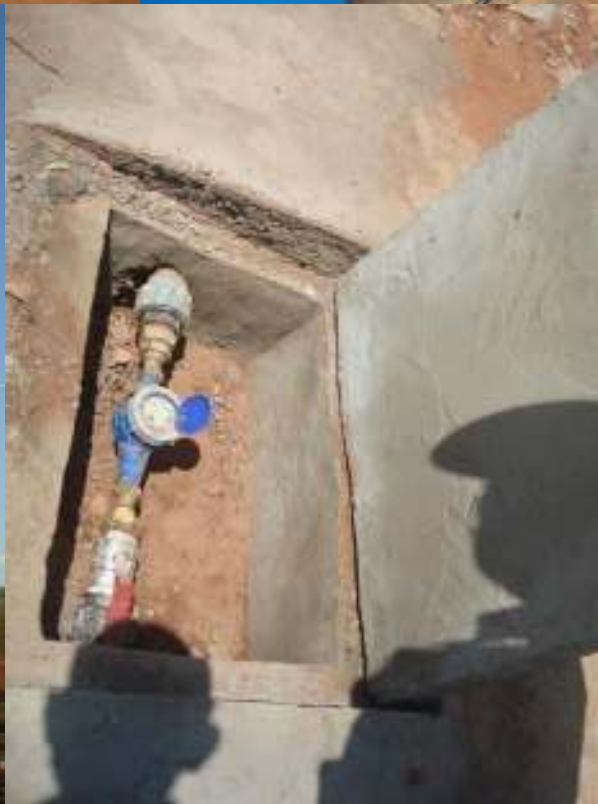
Composants de l'installation ; filtre, compteur, forage, château d'eau de TSARAFARITRA
