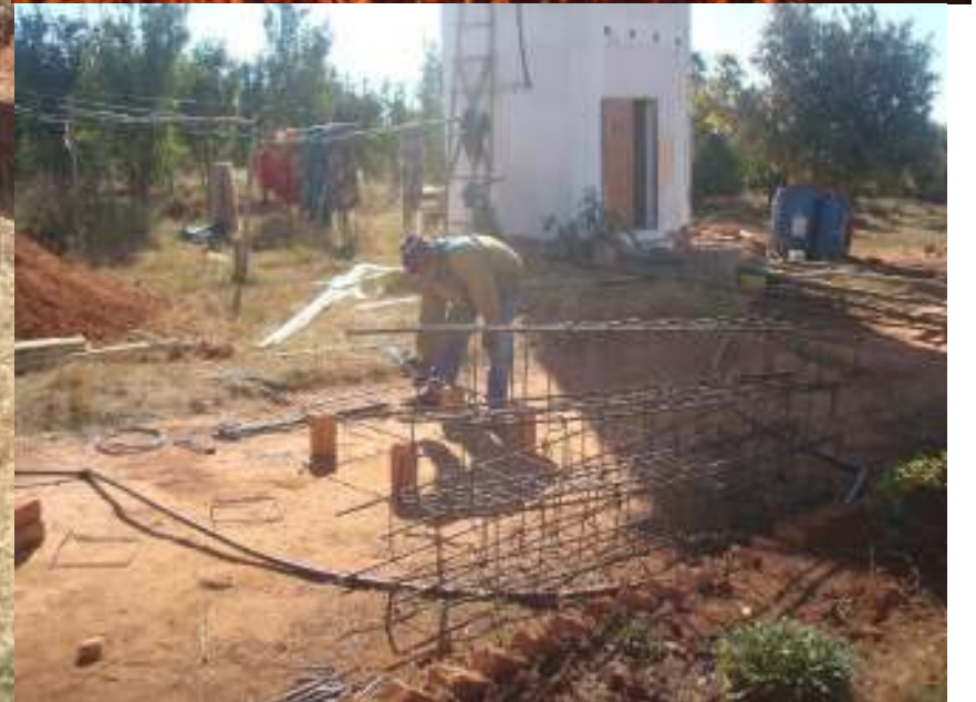
Réalisation des fouilles pour les massifs du château d'eau du site de TSARAFARITRA
