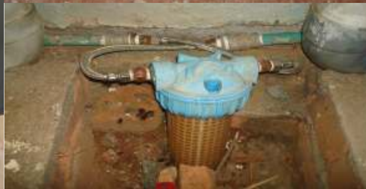
Composants de l'installation ; filtre, compteur, forage, château d'eau de TSARAFARITRA
