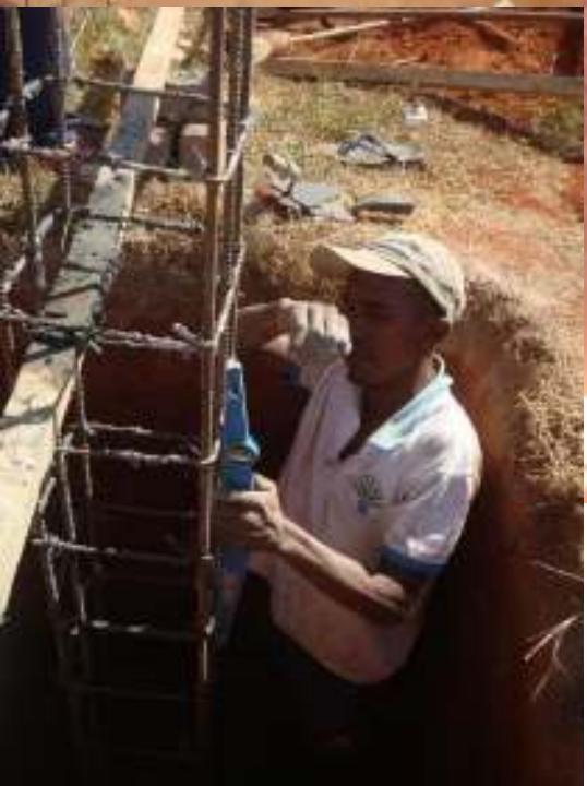
Ferrailage et bétonnage des massifs du château d'eau
