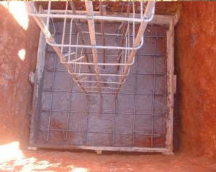
Ferrailage et bétonnage des massifs du château d'eau
